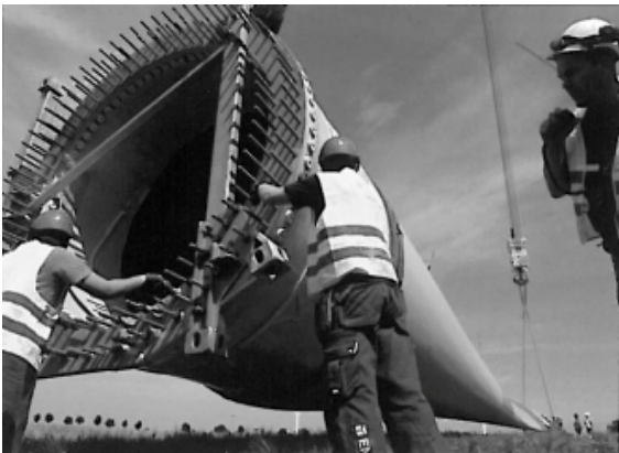
Abbildung 15: Zweireihiger Querbolzenanschluss [ENERCON, 2011]
