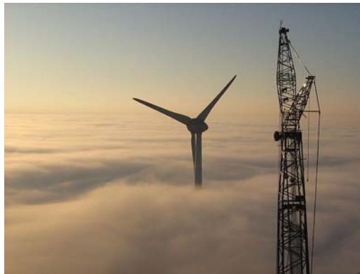
Abbildung 7: Enercon E-126 im Bau [Enercon - Wikipedia, 2011]
