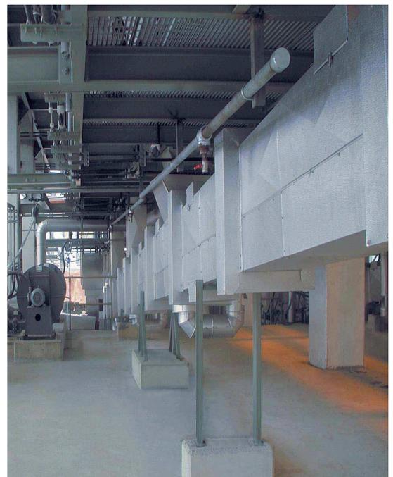
**Abb. 2: Luftförderrinnensystem von IBAU Hamburg**
