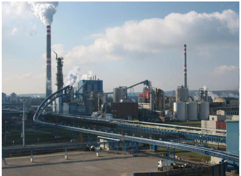
**Abb. 19: Rohrgurtförderanlage der Firma FMW
