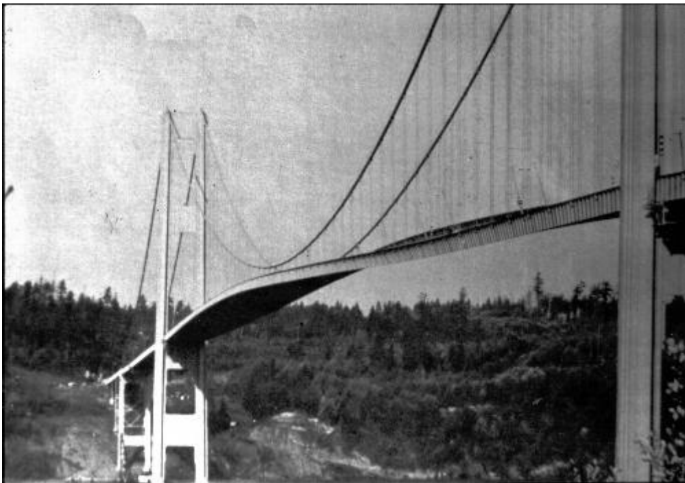
Abbildung 2.1: aeroelastische Schwingungsanfachung bei der Tacoma-Brücke kurz vor dem Einsturz [14].
