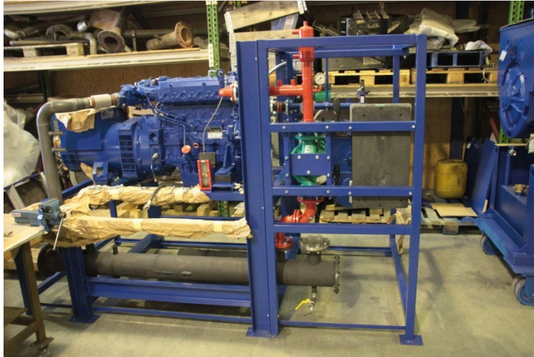
Abbildung 4-3 Rahmen verschraubt, Leitungen teilweise lackiert
