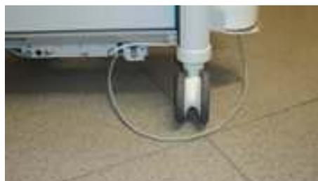
Abb. 5–6: Gefahr der Zerstörung des Netzkabels (Quelle: GPS GmbH)
