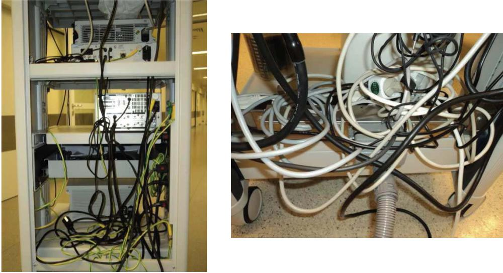
Abb. 5–3: Schlechtes Kabelmanagement (Quelle: GPS GmbH)
