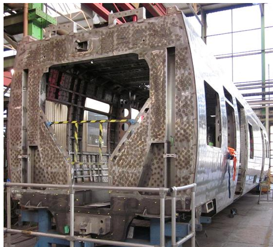
Abb. 1-6 Portal eines Wagenkastens Foto: [ALSTOM Transport Deutschland GmbH]
