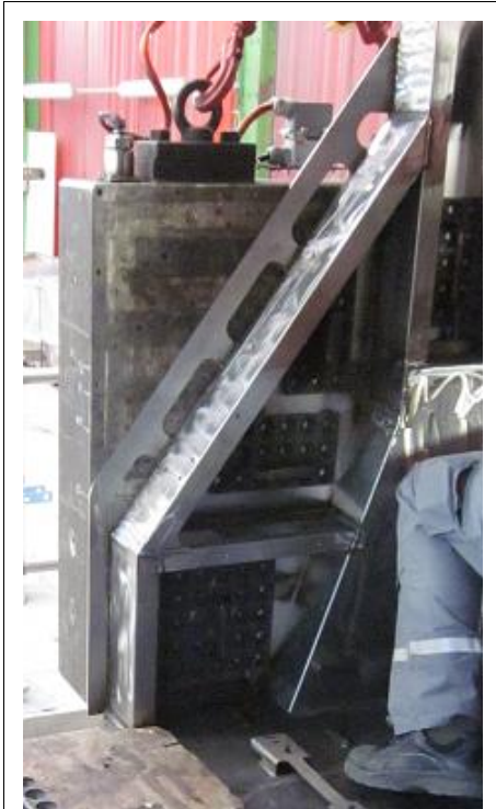
Abb. 1-8 Richten mit Magnetplatte Foto: [ALSTOM Transport Deutschland GmbH]
