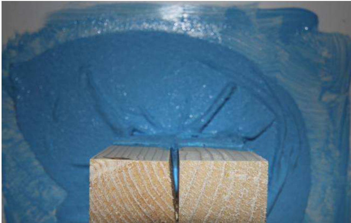
Abbildung 3.3.13: Komplett mit Masse verfüllter Riss
