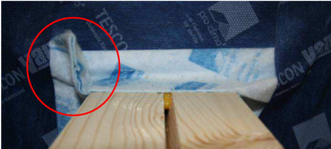
Abbildung 3.3.17: Dreieck aus überstehendem Anschlussband an der Balkenecke (nach Herstellvorgabe)
