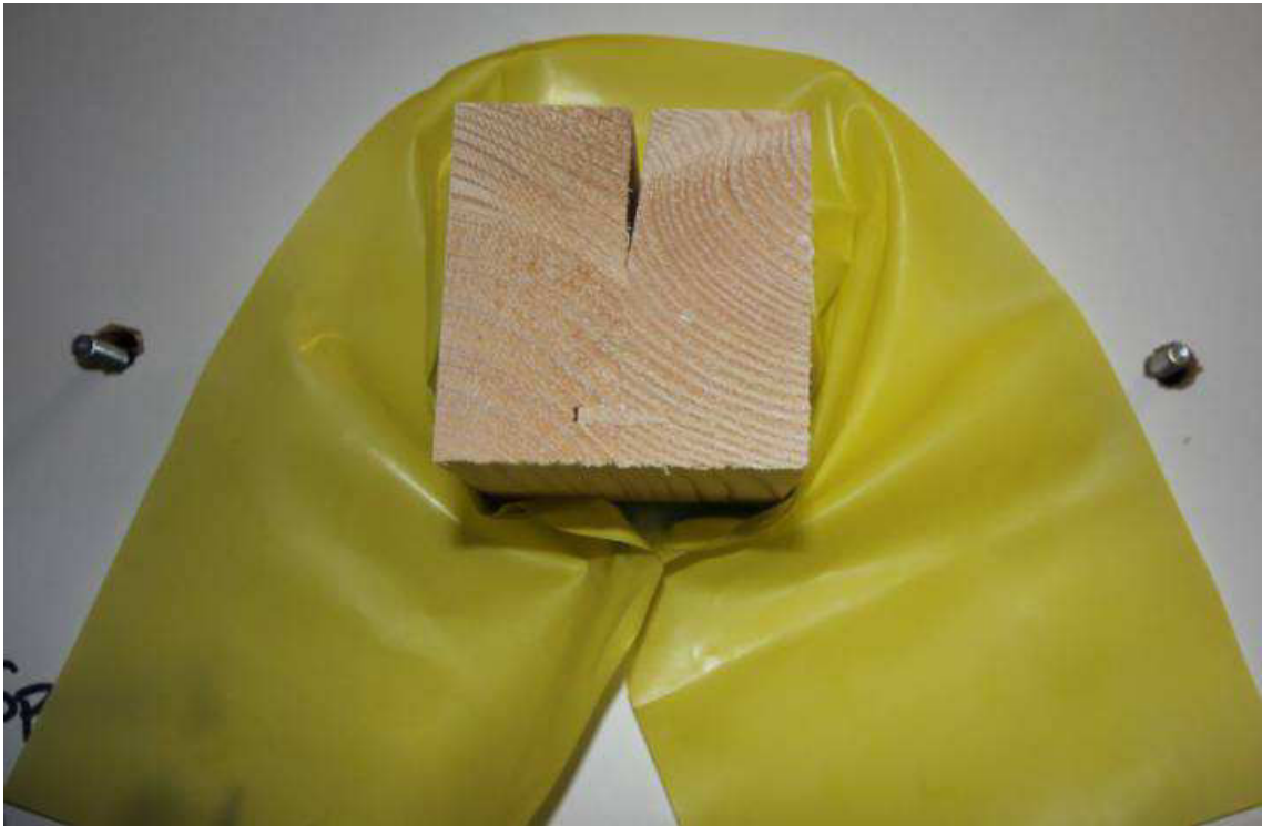
Abbildung 3.3.16: Ungenügender Andichtungsversuch mit Luftdichtheitsfolie
