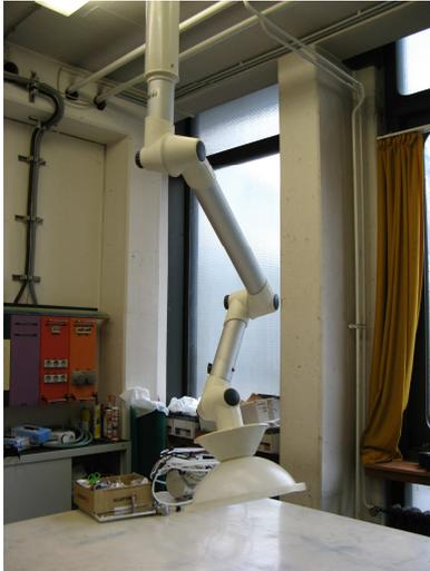
Abbildung 26 zeigt die bewegliche Absaugung über dem Arbeitstisch. Mit Hilfe der Gelenke kann die Absaugung direkt über die Quelle gebracht werden.
