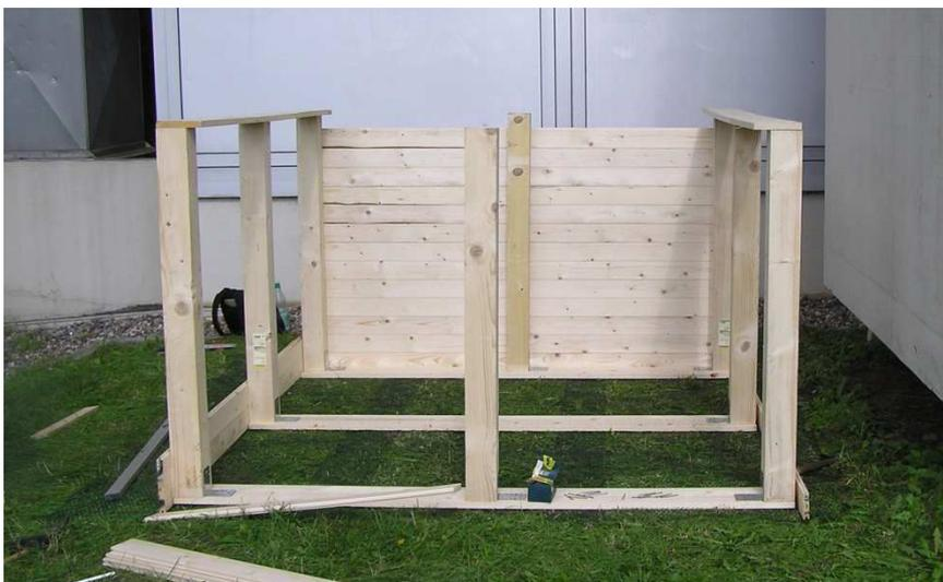
**Abb. 18: Das Grundgerüst des Behälters mit der ersten Seitenwand**
