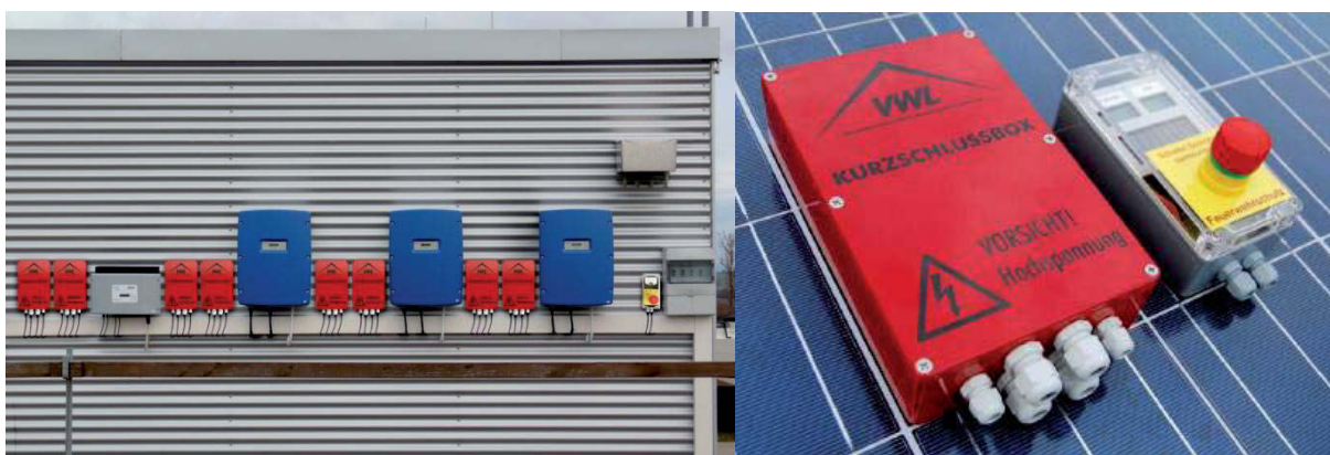
Abb. 4.17: beispielhafte Montage des FWS-112 (links) und Ansicht der Hauptkomponenten (rechts) [66]
