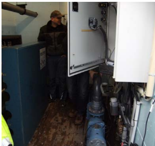
ABBILDUNG 11: ULTRASCHALLGERÄT IM CONTAINER VOR DER BIOGASANLAGE. ZU SEHEN IST LINKS DIE SCHUTZVERKLEIDUNG DES ULTRASCHALLGERÄTES, RECHTS UNTEN DIE PUMPE, DIE DAS SUBSTRAT BEFÖRDERT UND RECHTS OBEN DER KASTEN FÜR DIE ELEKTRONISCHE ANSTEUERUNG. NICHT IM BILD: HINTER DEM STEUERUNGSKASTEN BEFINDEN SICH DIE ULTRASCHALLGENERATOREN (EIGENES FOTO)
