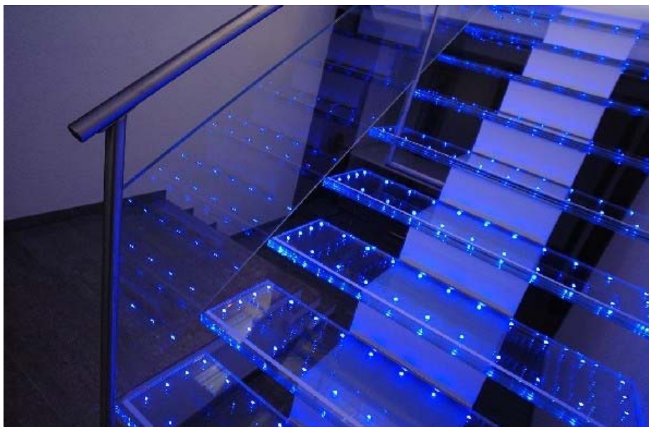
Abb. 15: Treppe mit LED-Beleuchtung,
