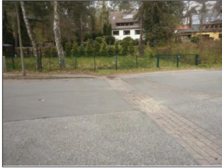
Abbildung 7 - Rinne, Ecke Forsthöhe/Forstgrund zum Versickerungsbecken; Quelle: Eigenes Foto.
