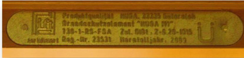
Abbildung 9: Kennzeichnungsschild einer T 30-RS Tür
