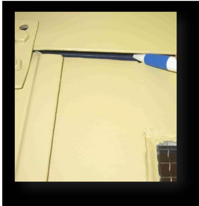
**Abbildung 15: Abschnittstür mit Spalt**
