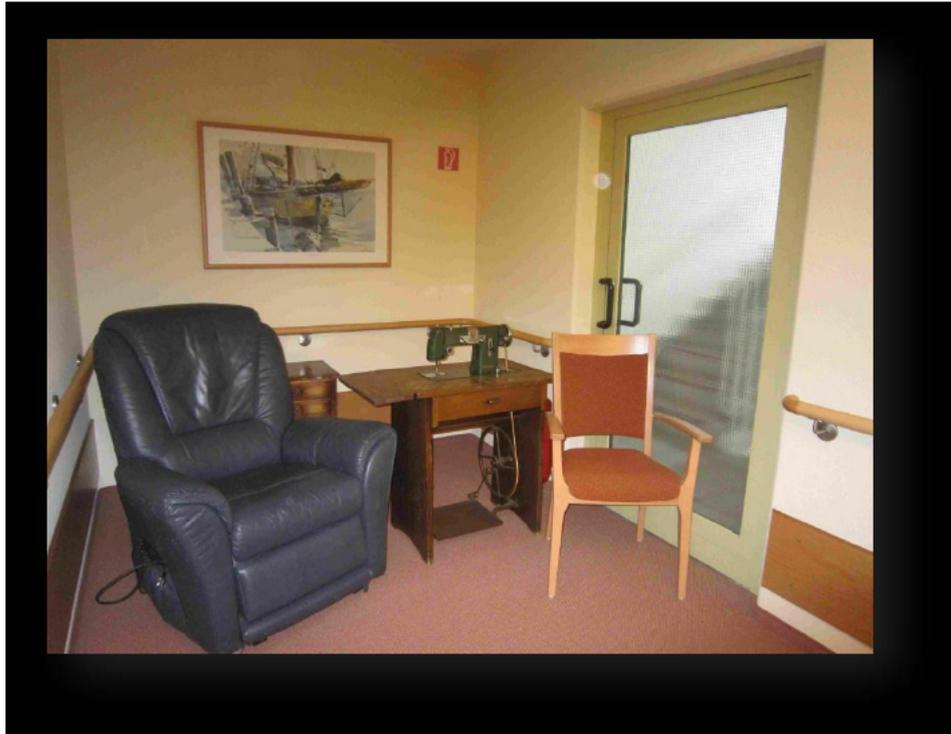
**Abbildung 16: Zugestellter Notausgang mit Stuhl, Brandlast durch Polstersessel**
