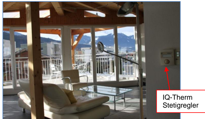
Abb. 110: Büro mit hohem Glasanteil und IQTherm Stetigregler
