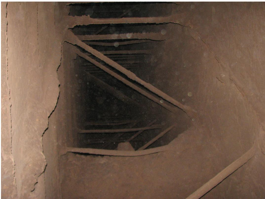
**Abbildung 2.3:** Mischkammer circa ein Dreivierteljahr nach der Reinigung, zu erkennen sind erhebliche Ansammlungen von Staubpartikeln und Anbackungen
