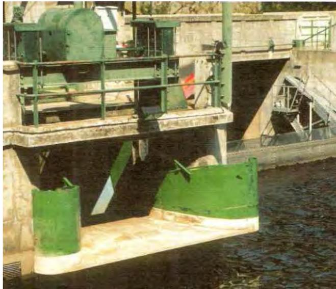
Abbildung 2.78 Höhenverstellbarer Bypass aus [17]
