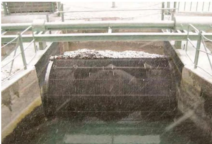
Abbildung 2.36 Frontal angeströmtes Trommelsieb (Schweiz) aus [17]
