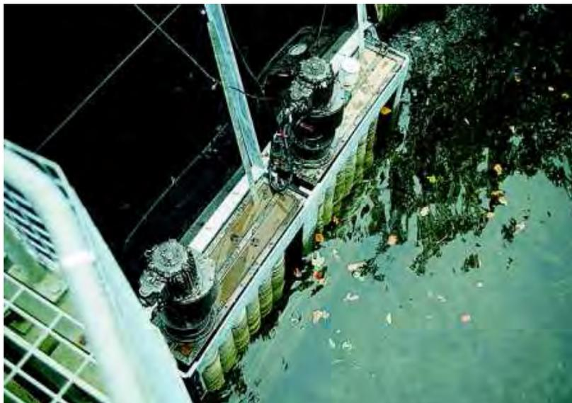
Abbildung 2.61 Installierte *Rotary Discreens* in Großbritannien aus [53]
