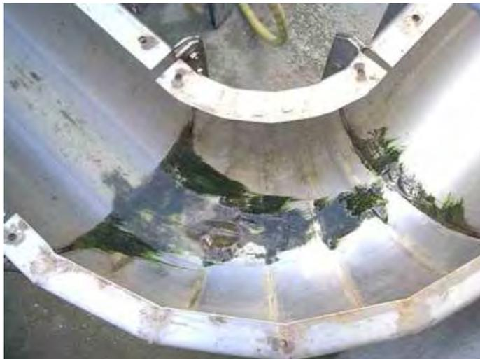
**Abbildung 2.75** Kurve in einem Fischrückführungssystem aus [53]
