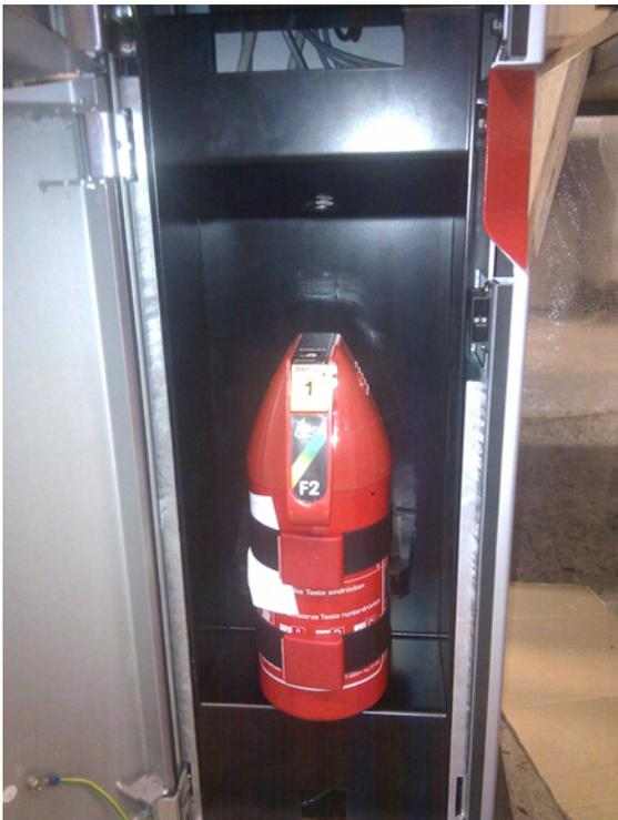
**Abbildung 11:** Innenausbau der neuen Meldesäule mit Feuerlöscher; Quelle: eigene Aufnahme
