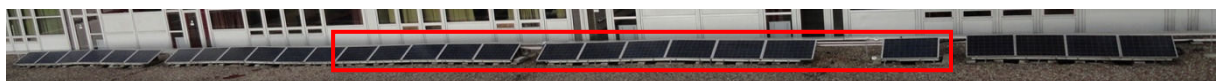
Bild 14: Netzgekoppelte Anlage und Inselanlage (mit dem Ost-Strang als markiertem Bereich)(Quelle: Eigene Bilder)
