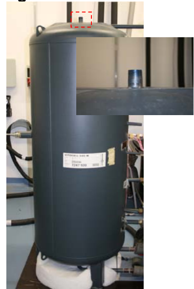
Abbildung 4.7: Anschlussstutzen auf dem Speicherdeckel
