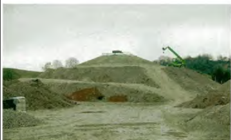
Anfüllen des Speicherdeckels, um diesen begrünen zu können
