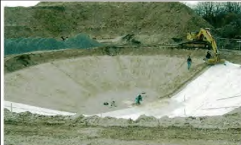
Einbau von 20 cm Schaumglasschotter als untere Dämmlage, Vliesabdeckung
