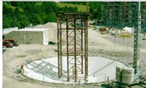
Betonierter unterer Kegelstumpf, manuell abgezogen, mit Rüstturm
