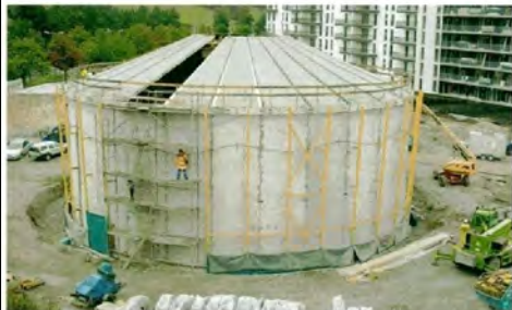
Schließen des Speicherdeckels mit zwei gegenüberliegenden Sonderfertigteilen zur Aufnahme der Vorspannanker. Montagebeginn der Holzunterkonstruktion für die Membranschalung der Wand
