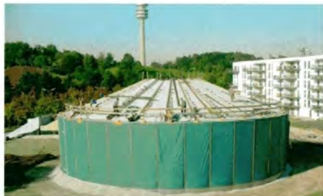
Schrittweises Füllen der Membranschalung mit Blähglasgranulat und Anfüllen von außen
