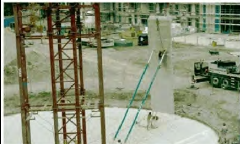
Montage der Wandfertigteile (Wandstärke 16 cm) mit vormontierter innerer Edelstahlaußenkleidung aus 1,2 mm Edelstahlblech, überlappend verschweißt
