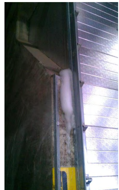
Abbildung 20: Seitlicher Schaumaustritt
