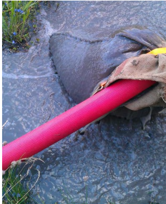
Abbildung 14: Erste Spülung durch einen Jutesack
