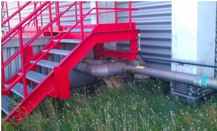
Abbildung 9: Wasserleitungen auf dem Dach der Anlieferhalle
