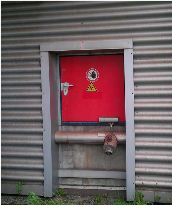
Abbildung 8: Löschoffnung auf dem Dach der Anlieferhalle
