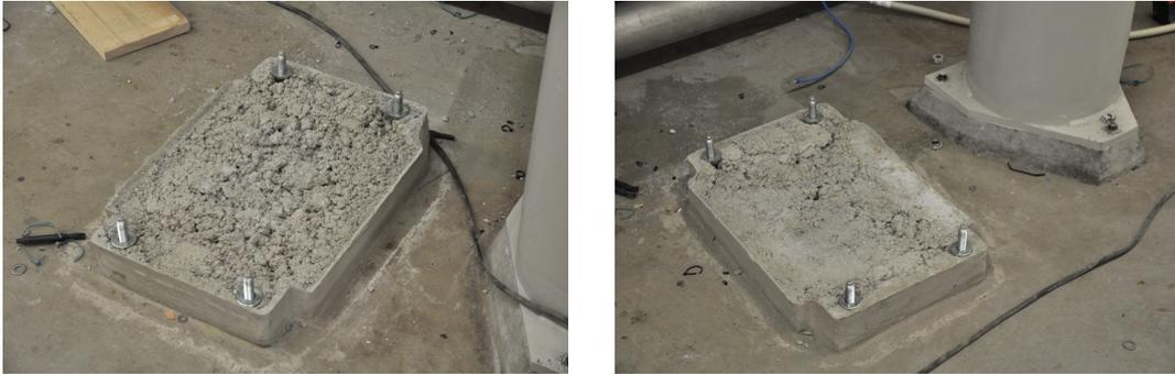
Abbildung B.4.: PETRA Abriss Februar 2014: Demontage der Untergestelle und damit freie Sicht auf das Quellbetonfundament
