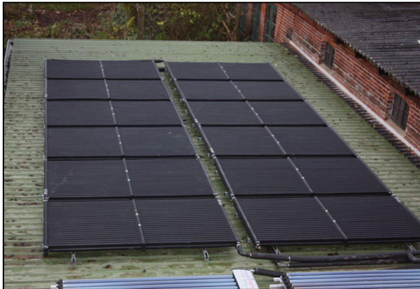
Abbildung 13: Röhrenabsorber auf einem Flachdach
