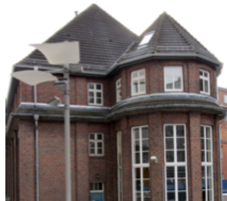
Abbildung 2.1.: Bestandsgebäude der HAW
