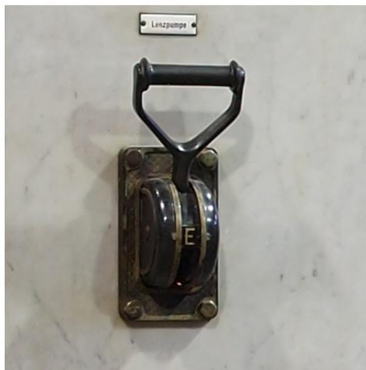
Abbildung 2.5: : (a) Foto eines Einhandhebels [Quelle: Schalttafel]
