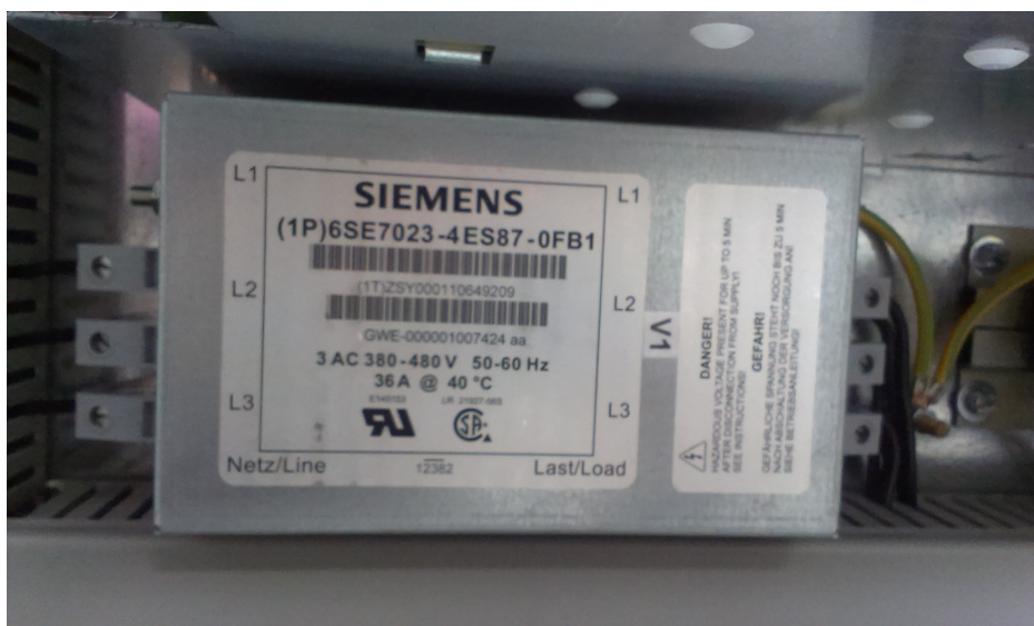
Abbildung 4.3: Eingesetzter Netzfilter
