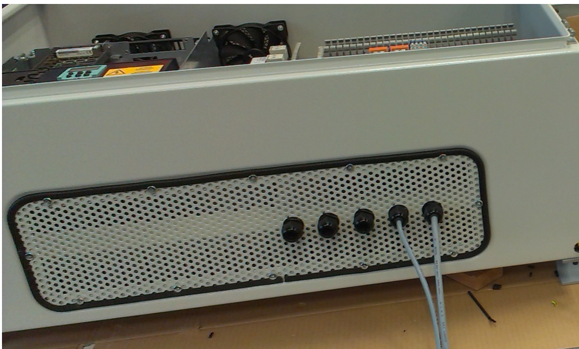
Abbildung 4.14: Lochblech zur Belüftung und Kabeldurchführung
