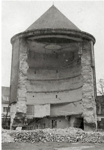
Abbildung 3.2.: Innenansicht eines Zombeck-Turmbunkers [Dec14]
