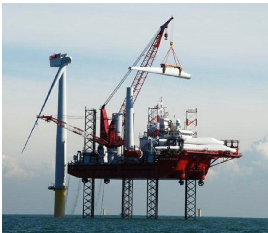
Abbildung 3.5.: Einzelblattmontage offshore von einer Jack-Up-Plattform aus [3]
