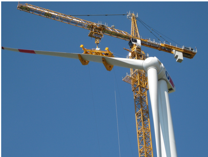
Abbildung 3.2.: Montage eines Rotorblattes mit einem C-Haken [6]
