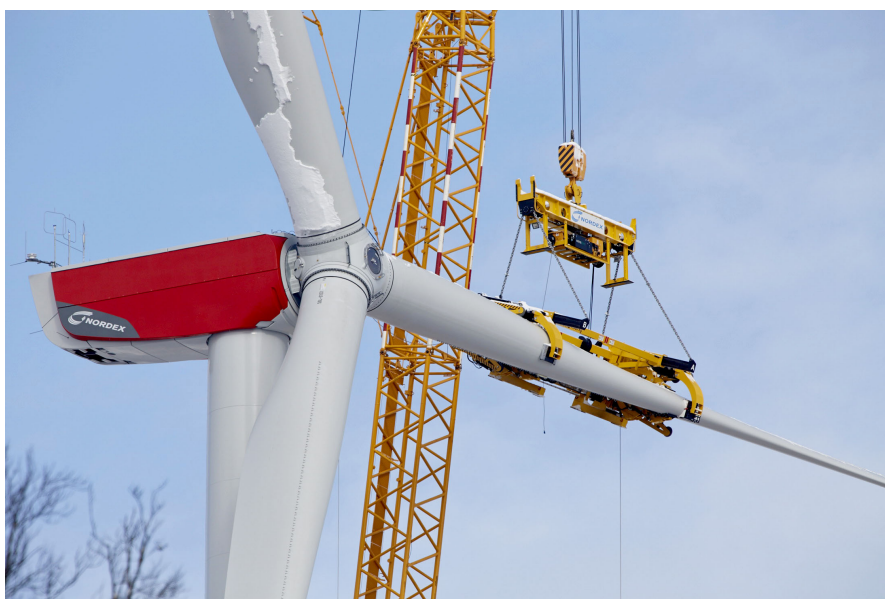
Abbildung 3.4.: Einzelblattmontage mit einer Blatttraverse [4]
