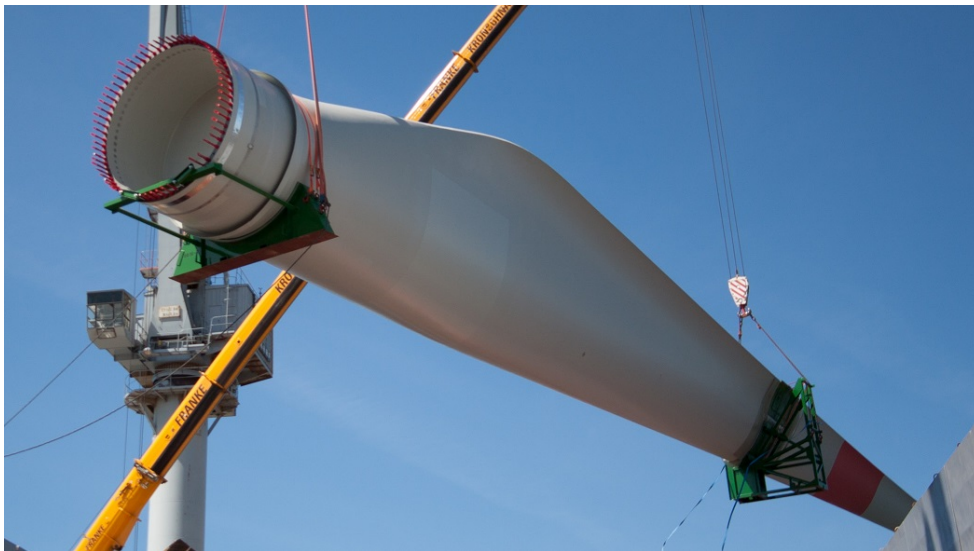
Abbildung 1.6.: Kranhub eines M5000-116 mit Nearshoregestellen bei der ersten Auslieferung auf dem Seeweg [14]
