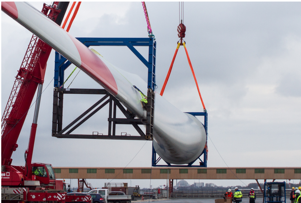
Abbildung 3.7.: Kranhub der Rotorblätter in den Gestellen [14]
