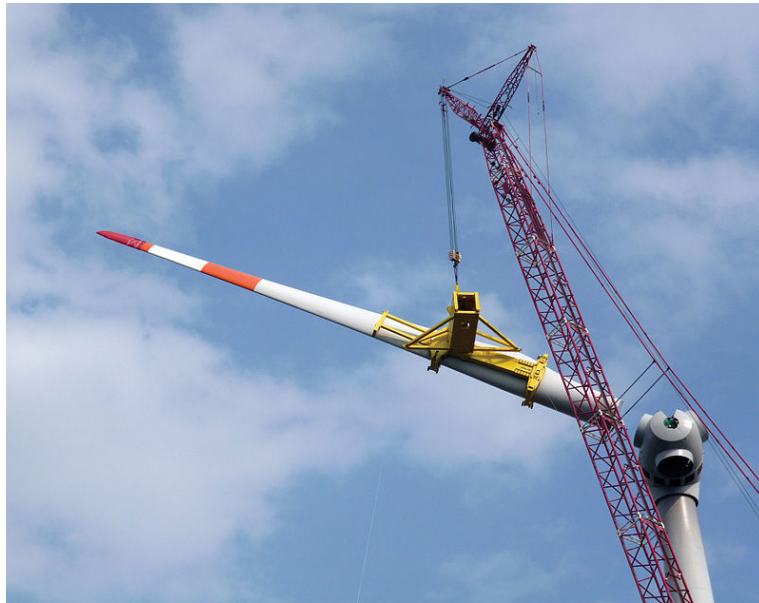
Abbildung 1.5.: Erprobung der Einzelblattmontage mit einem speziellem Hebemittel an einem Prototypen der M5000 in Bremerhaven [2]
