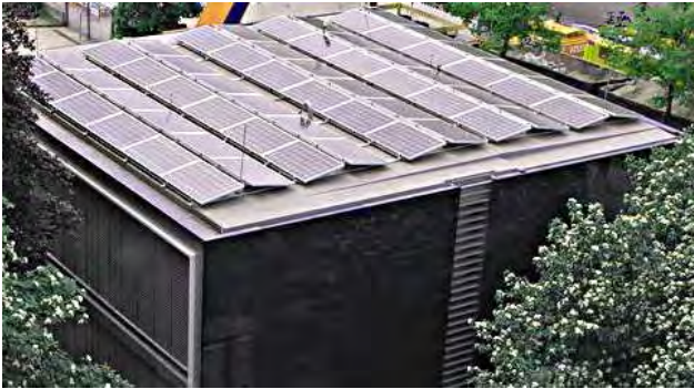
Abb.3-7 Blick auf das Dach von Nord-Ost (Quelle: ENBAUSA 2014)
