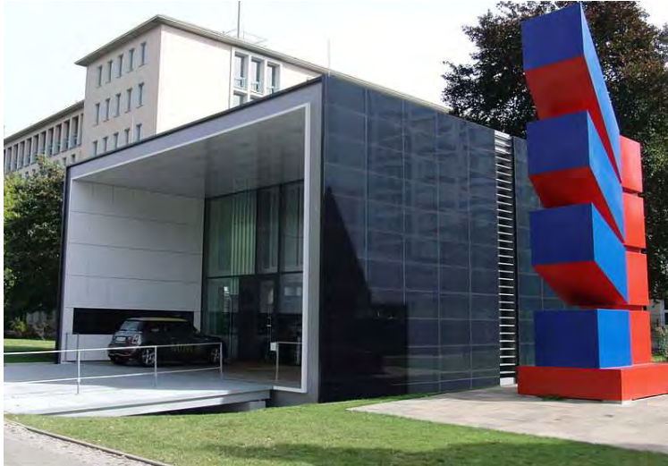
Abb.3-8 Blick auf die Südfassade (Quelle: Manu 2014)
