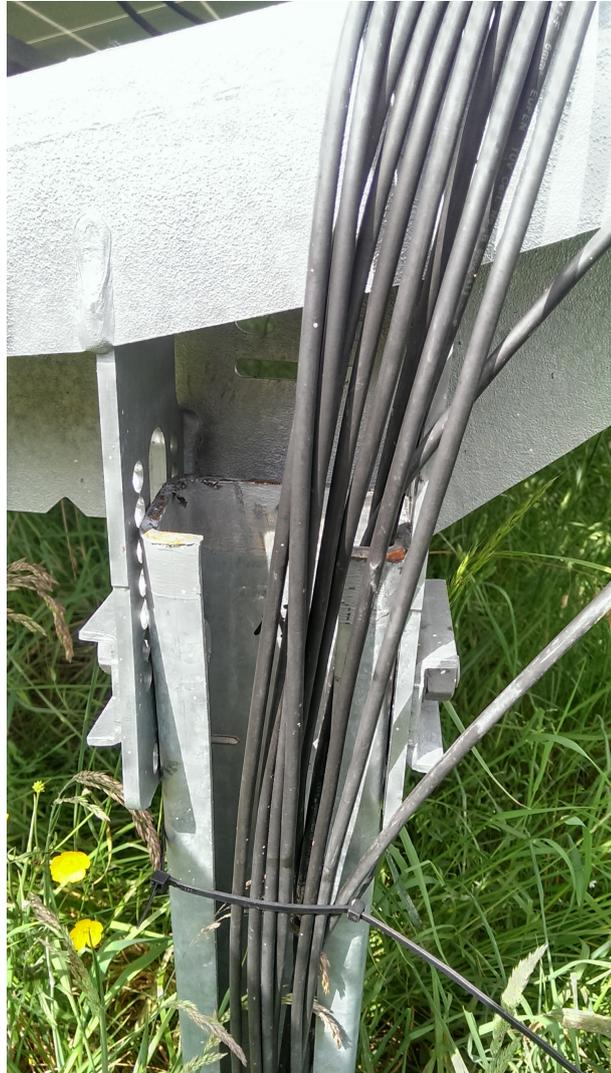
Abbildung 9.3: Fehlerhafte Leitungsverlegung Quelle: (Eigenes Foto)
