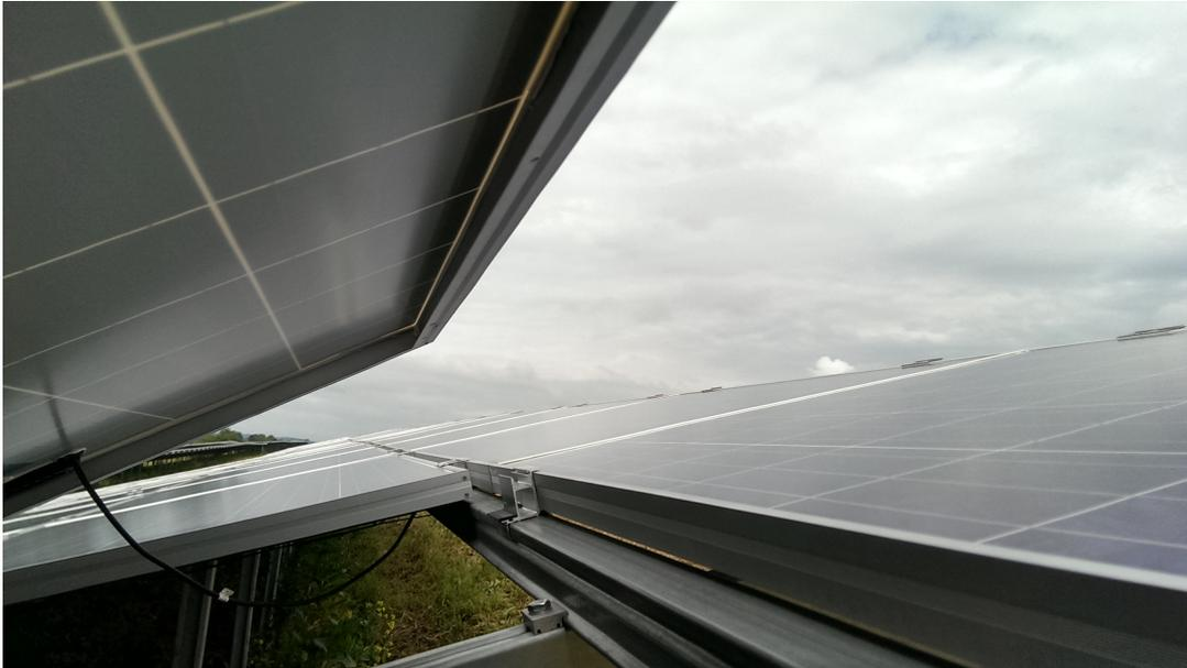
Abbildung 9.4: Fehlerhafte Modulhalterung Quelle: (Eigenes Foto)
