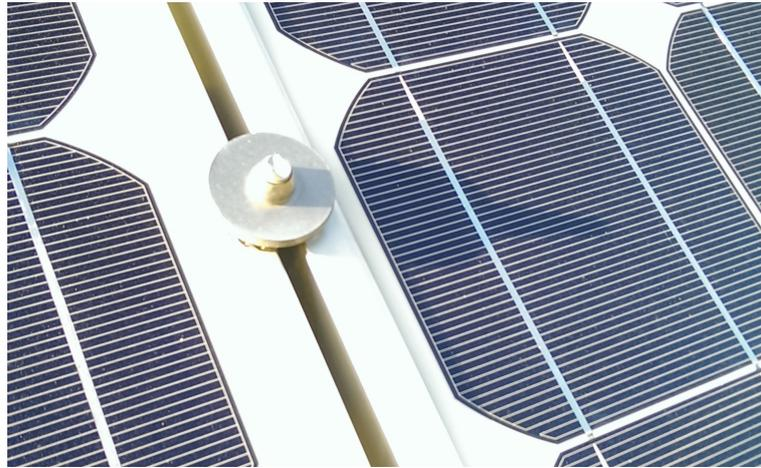
Abbildung 6.6: Modulhalterung verschattet Solarzelle. Quelle: (Eigenes Foto)
