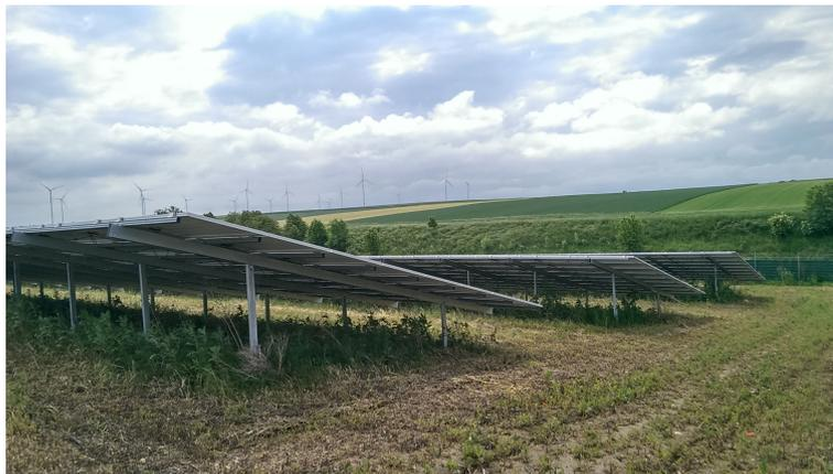
Abbildung 4.2: Unterkonstruktion Photovoltaikmodule. Quelle: (Eigenes Foto)
