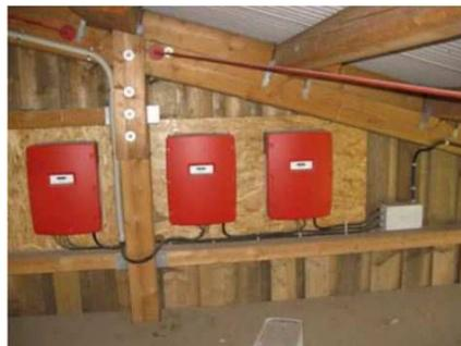
**Abbildung 3.5: Wechselrichter auf brennbarer Dachkonstruktion**
