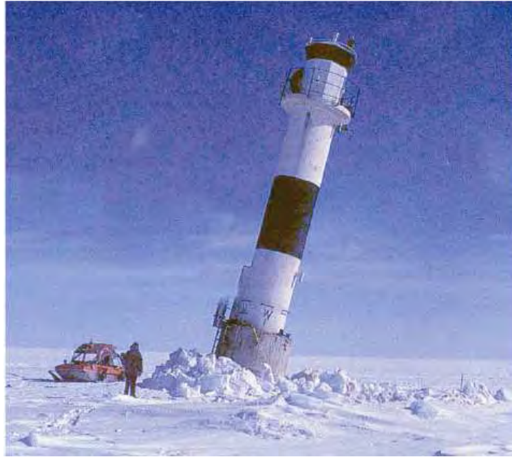
Abbildung 1-1: Schaden durch Meereis am Leuchtturm „Björnklacken“ (D = 2,9 m) im Jahr 1985.
