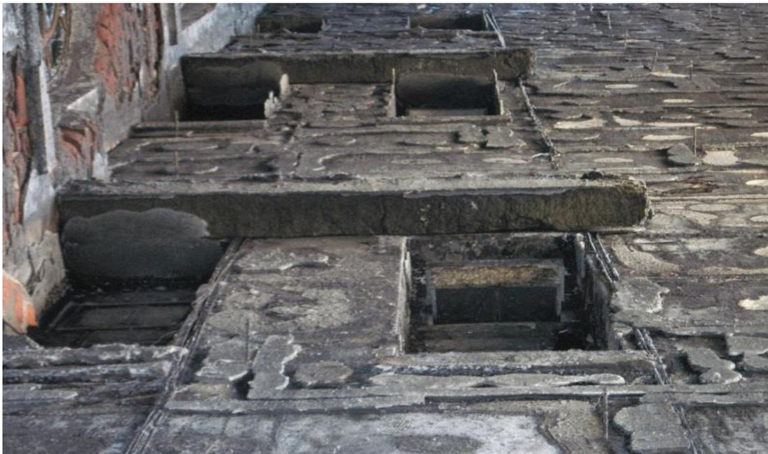
Abb. 14: Das abgebrannte WDVS auf der Gebäuderückseite<sup>132</sup>
