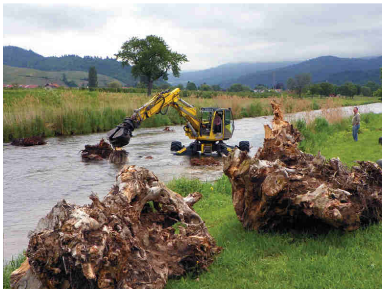
Abb. 7: Wurzelstöcke zum Einbau in die Gewässersohle der Elz ( www.lfvbaden.de )
