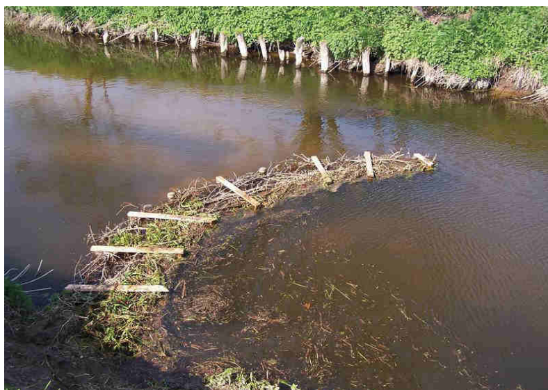
Abb. 6: In das Gewässer hineinragende Faschine ( www.asv-nienborg.de )
