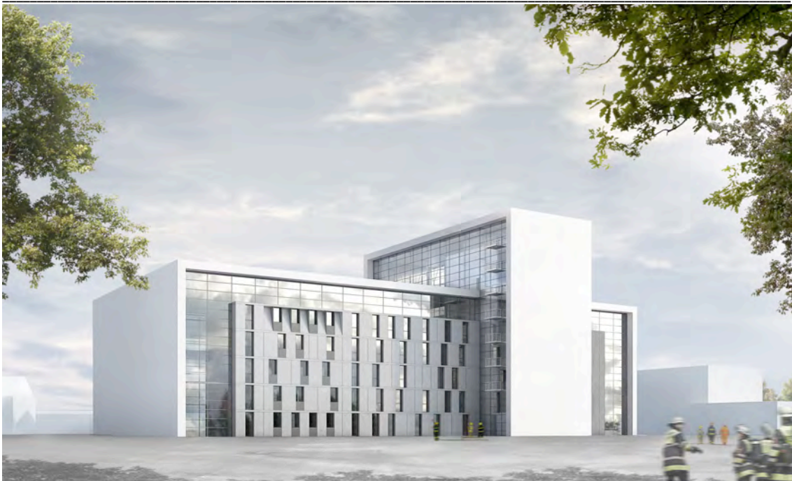
Abb. 15: Westfassade der im Bau befindlichen neuen Übungshalle der SFSW
