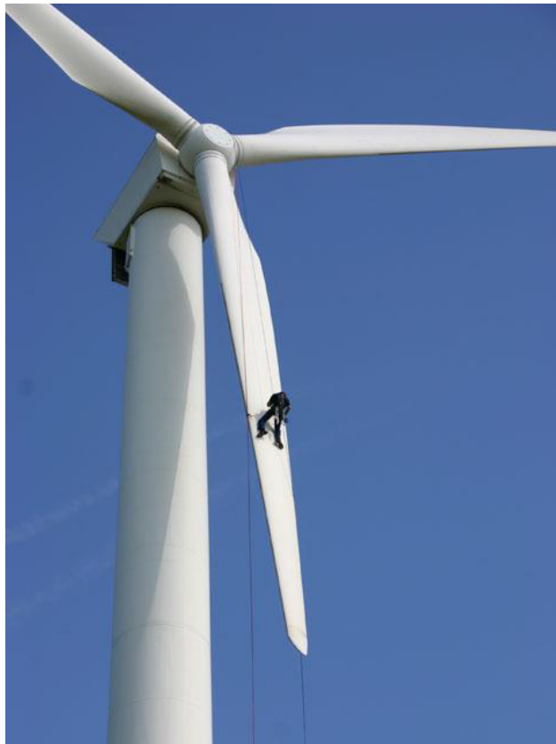
Abbildung 0.8 Rotorblattwartung [50]
