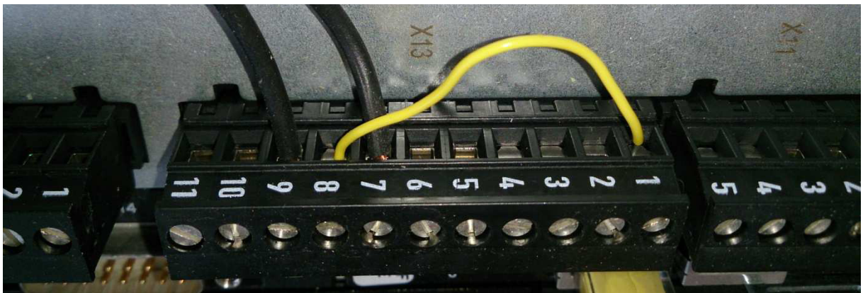
Abbildung 44: Überbrückung der Anschlussstelle X13 des DFE33B
