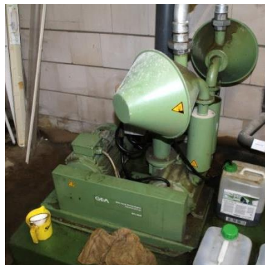
Abbildung 14: Vakuumpumpe Westfalia-Surge 2800 (Eigenes Foto, 03.06.2015)
