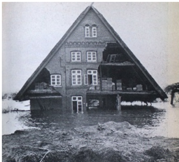
Abbildung B.19: Ausmaße: Zerstörtes Bauernhaus Moorburg. (Freie und Hansestadt Hamburg, Schulbehörde o.J.: 33)
