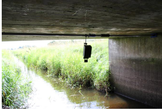
Abb. 14 Montage mit Teleskopstange in einem Rahmendurchlass
