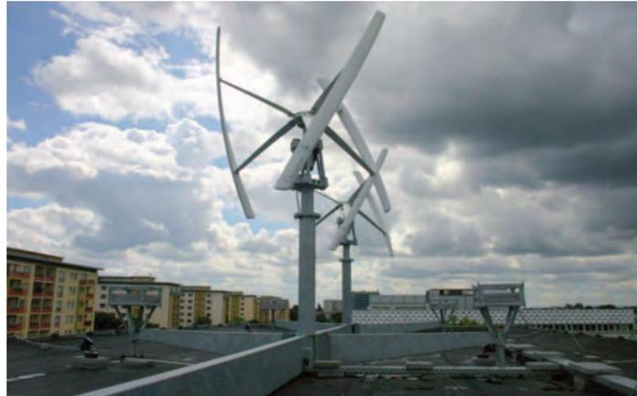
**Abb. 3.5:** Beispiel einer Montage auf einem Flachdach: Anbindung an die oberste Geschosdecke mittels Stahlträgern [Bolsius 2014]
