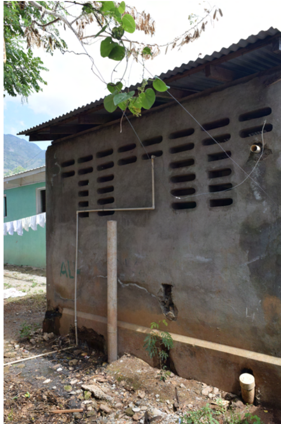
Abbildung 4: Septic tank unterhalb von B12
