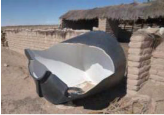
Abb. 23: Durch einen Sockeleinsturz zerstörter Wassertank [Energética]
