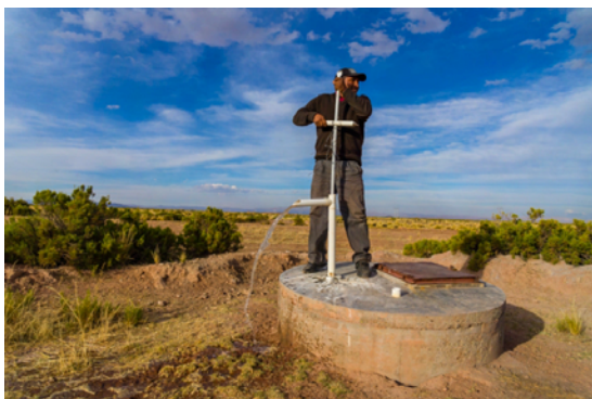
Abb. 5: Eine manuelle Wasserpumpe im Hochland
