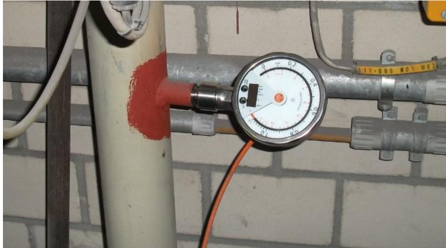
Abbildung 5.3: Drucksensor in der Druckluftleitung
