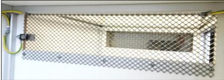
**Abb. 6.5:** Lüftungsgitter zwischen Modul- und Elektronikammer
