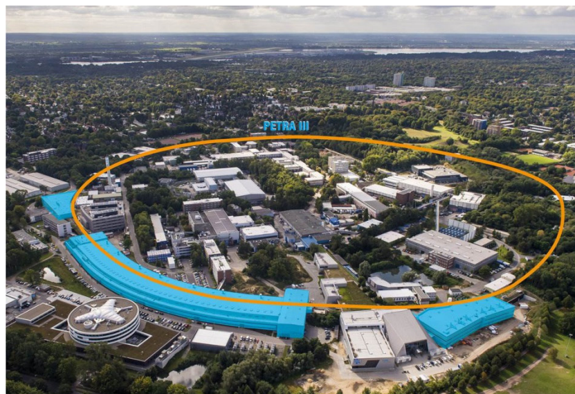
Abbildung 3: Luftbild Ringbeschleuniger PETRA III mit Experimentierhalle und Erweiterung Entnommen aus Quelle [3]
