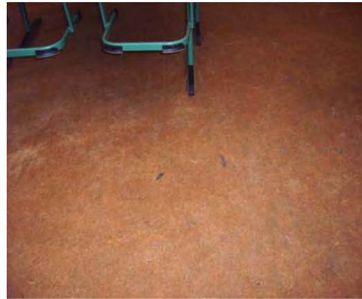
Abb. 11: Beschädigter Fußbodenbelag
