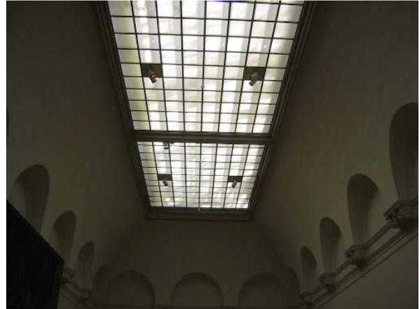
**Abbildung 10: Glasdecke in R. 135 mit zusätzlichen Strahlern**
