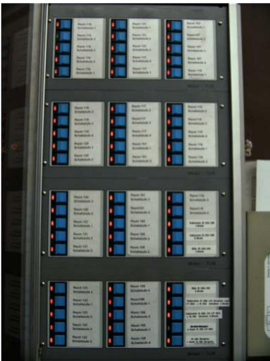
**Abbildung 26: Schaltfeld der Beleuchtung im Neubau**
